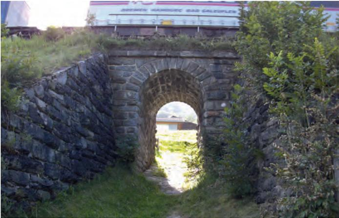
Gemauerter Durchlass an der Tauernbahn beim Einfahrsvorsignal des Bahnhofs Angertal
